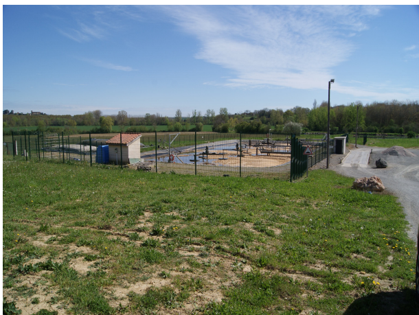
VUE GENERALE DEPUIS L'OUEST
