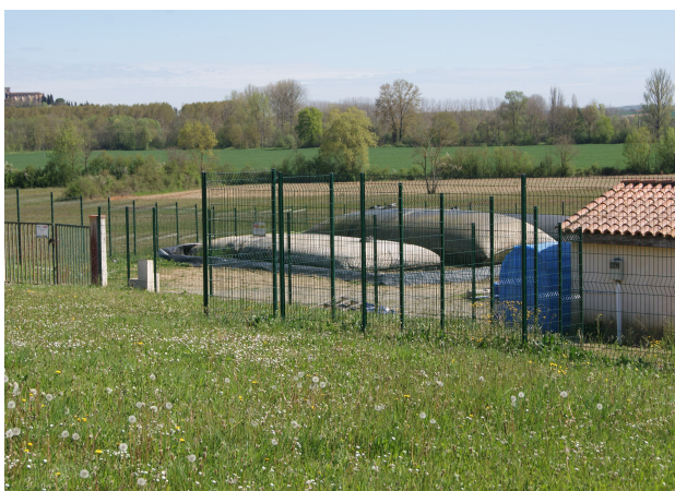
VUE DES GEOTUBES
